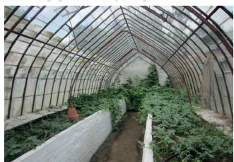
afb. 307. Interieur kweekserre met spitsvormig dak
